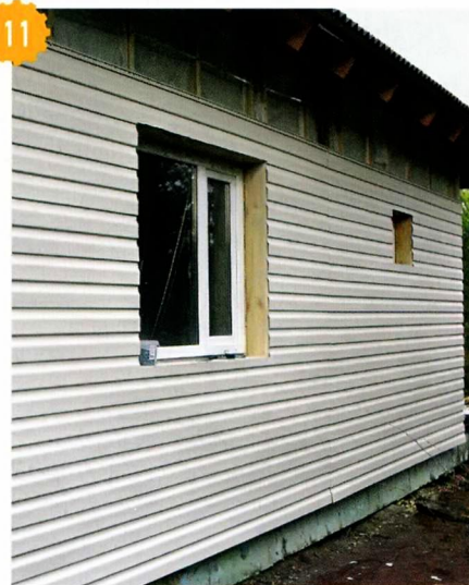
Отделанная сайдингом стена без доборных элементов первоначально выглядела немного странно...
