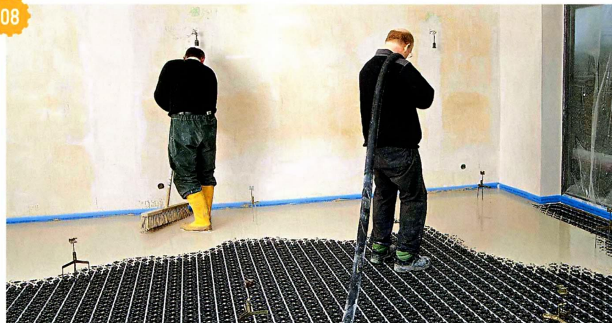
08 Трубы водно-циркуляционной системы обогрева пола испытывают при повышенном давлении и только после этого заливают бетонной стяжкой.
