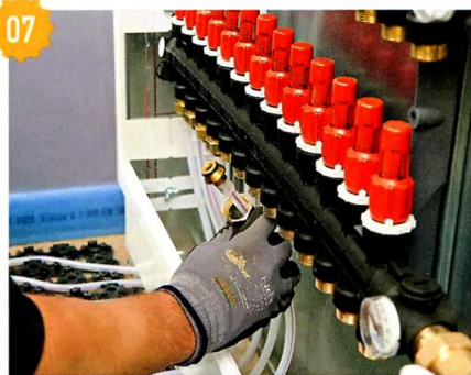
07 Выложенные из труб змеёвки подсоединяют к распределительному коллектору.
