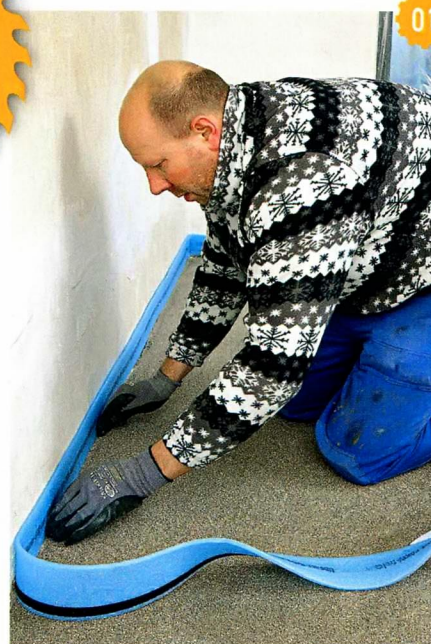
Демпферную ленту крепят к стене по всему периметру помещения.
