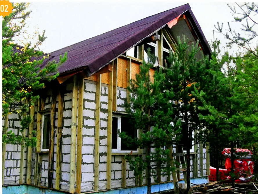
Обрешётку для монтажа утеплителя и сайдинга сделали из доски шириной 150 мм.
