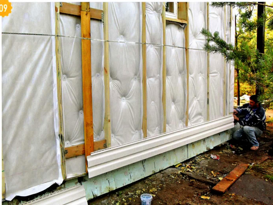
Монтаж сайдинга по нестандартной технологии без доборных элементов. Под место стыков панелей пришлось установить опорную доску.
